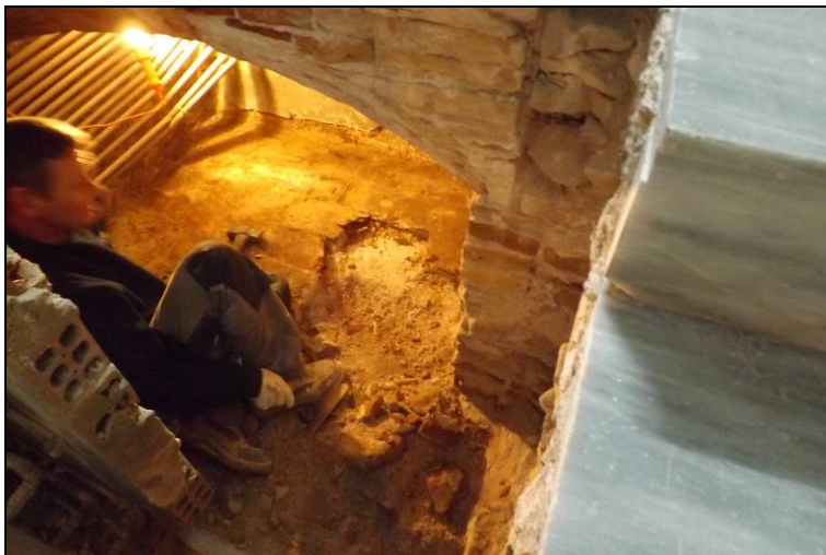
Afectació paviment UE 108
