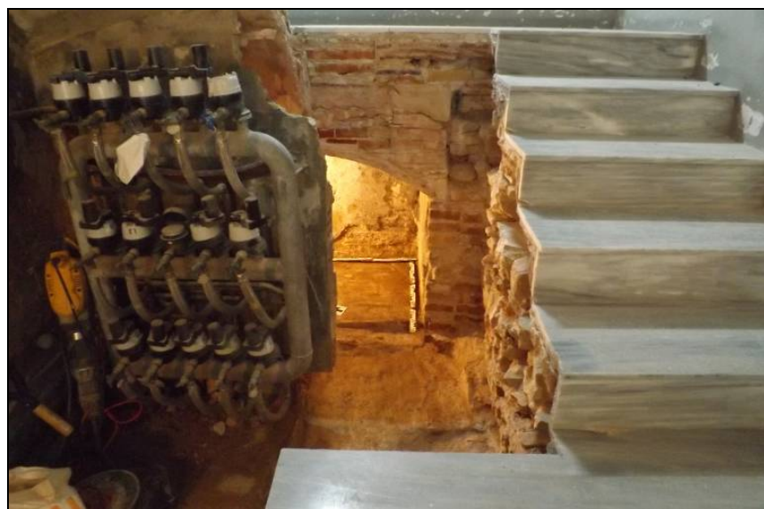
Vista general del sector
