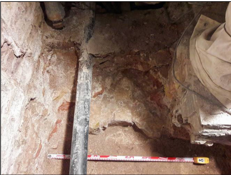
A dalt la columna que sustenta l'arc triomfal i a sota la trava UE 208
