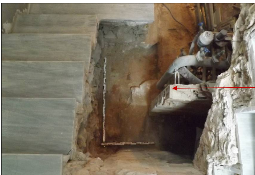
L'envà UE 124 vist en planta durant l'afectació del paviment UE 107
