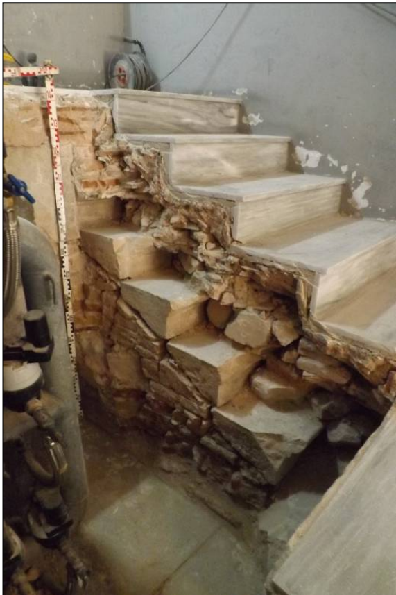
Vista en alçat on es veuen les dues escales de la finca
