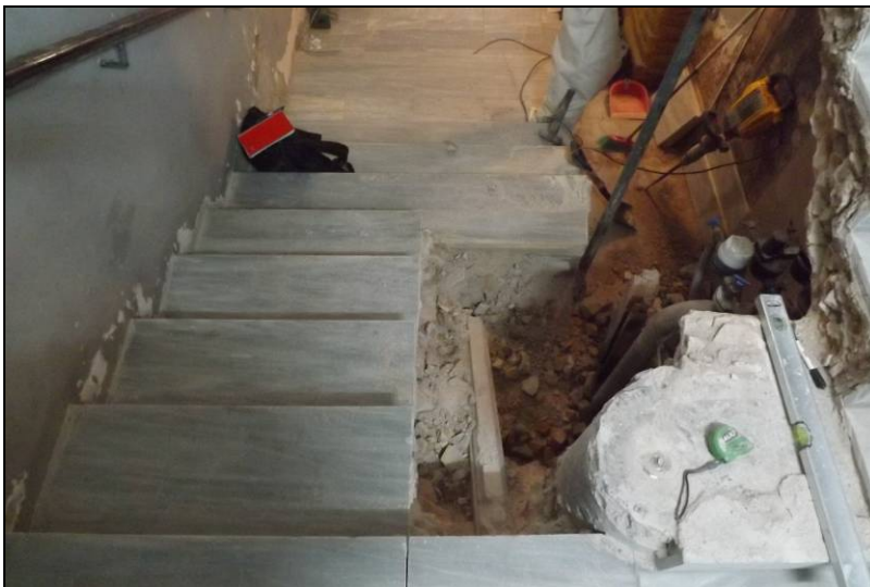
Marcatge i afectació de part del primer tram de l'actual escala
